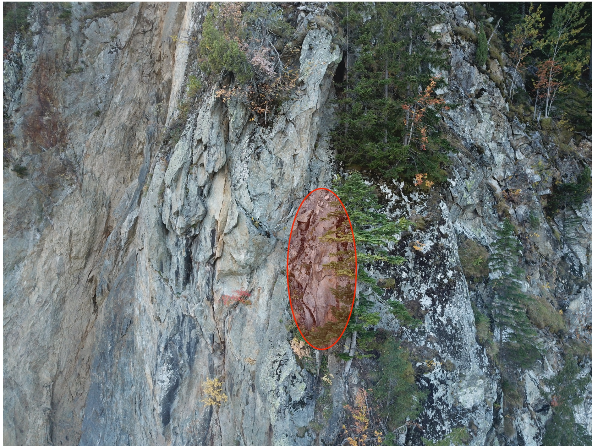
Localisation d'un compartiment de 25 m 3 à miner
