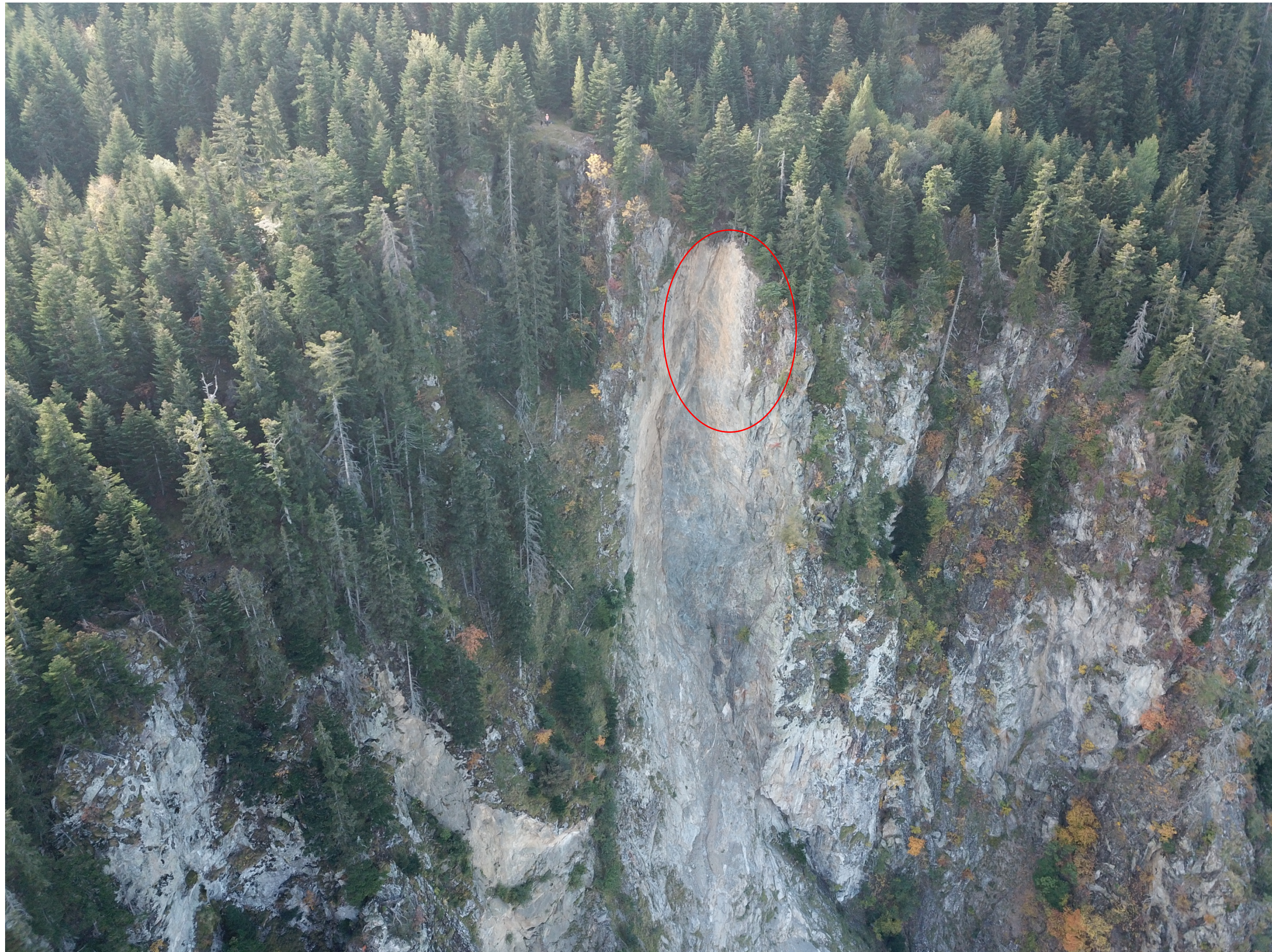
Vue générale de la partie supérieure de la falaise avec localisation de la zone de départ de l'éboulement de janvier 2016
